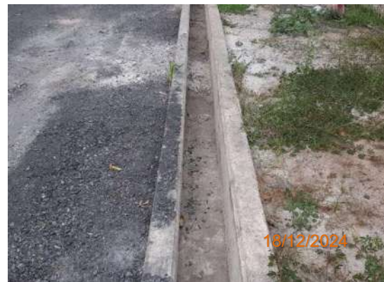
รูปที่ 2-10 รางระบายน้ำฝนในพื้นที่ก่อสร้าง
