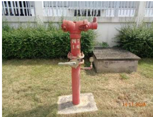
รูปที่ 2-40 Fire Hydrant ภายในพื้นที่โครงการ
